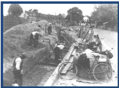
In 1934 werd in het kader van de 'werkverschaffing' riolering aangelegd in de Koningin Julianaweg in Leidschendam (Foto gemeente-archief).
